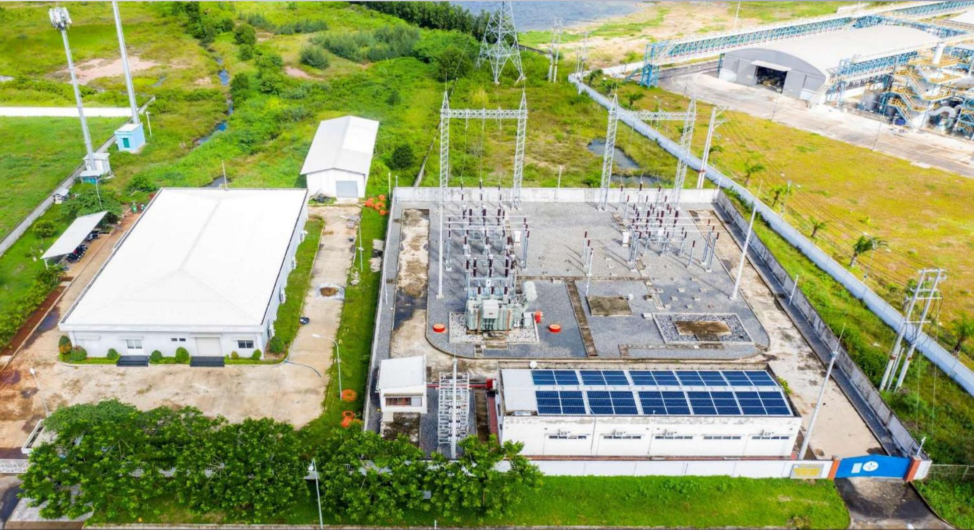
2キロ先の変電所から、高圧110KV送電線を工業団地内変電所に引込み22KVに変圧後
