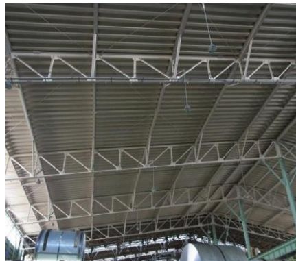
屋根の裏面の温度を計測
