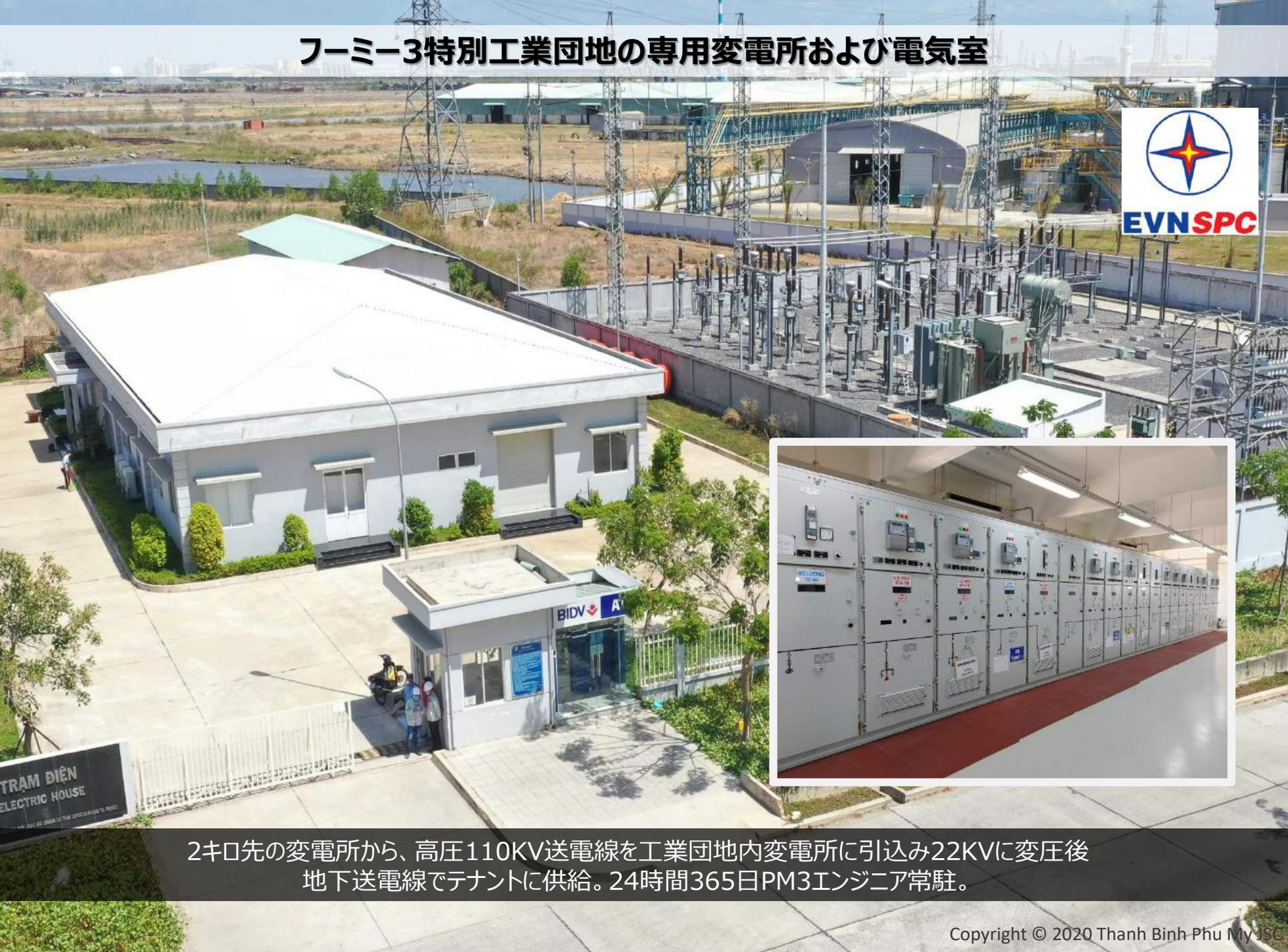
2キロ先の変電所から、高圧110KV送電線を工業団地内変電所に引込み22KVに変圧後
